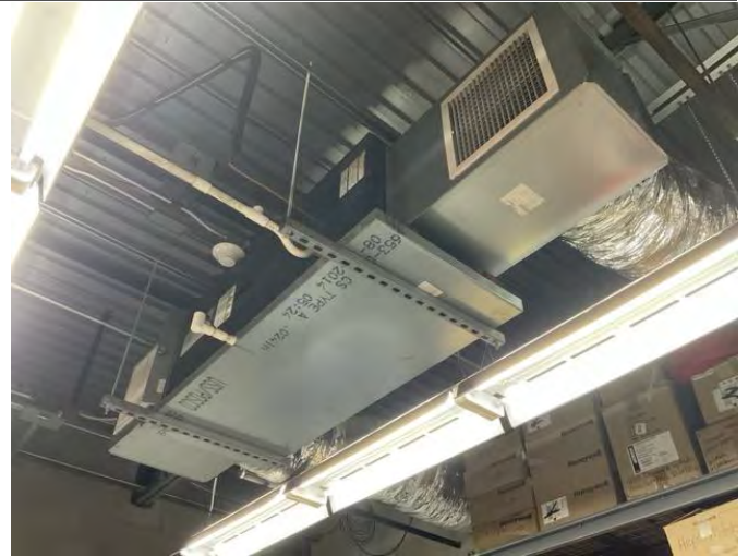
26 - HVAC FAN COIL UNIT
